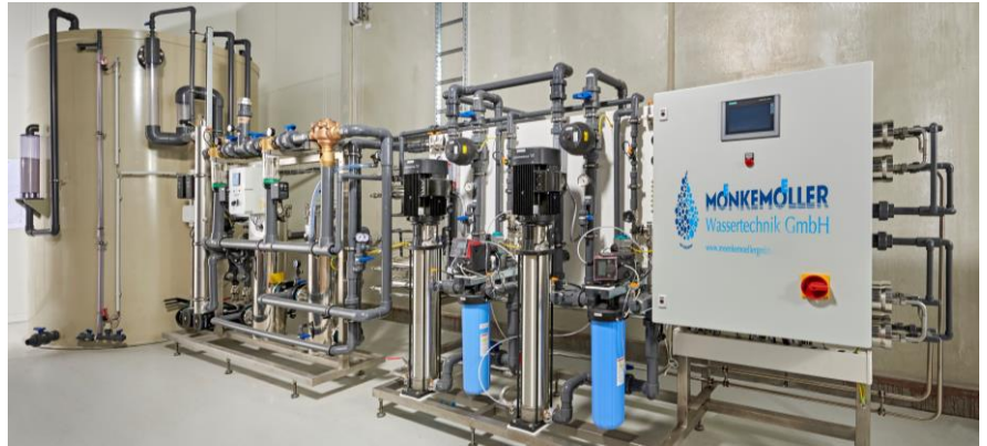
Silikonfreie Reinstwasser Anlage
