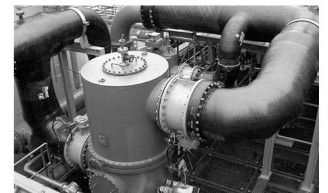
FIOLA AQUAPROTECT (Einbau in Rohrleitung)
